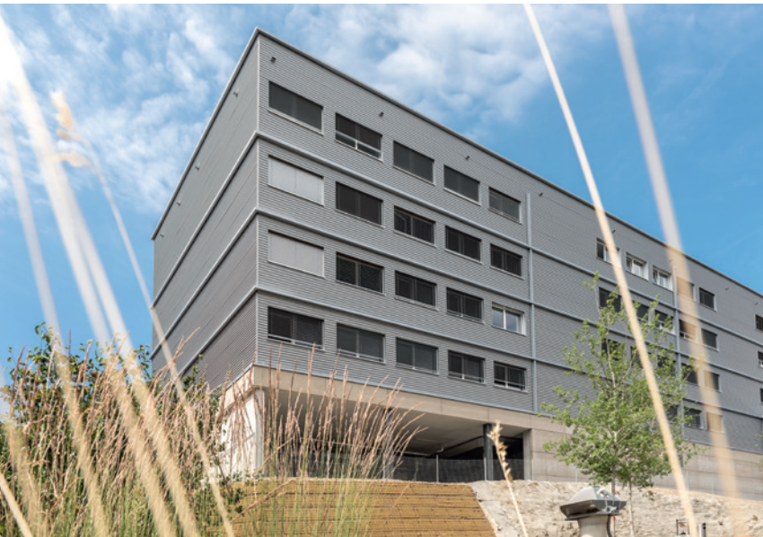
Rochadegebäude Inselspital Bern: 4-stöckig auf 5000 m 2 . Das Gebäude war davor als Alters- und Pflegeheim in Muttens im Einsatz; Umplatzierung nach Bern und Erweiterung um 800 m 2 .
