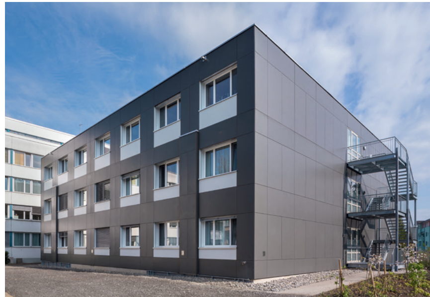
Bettentrakt Spital Lachen: 3-stöckiger Bettentrakt der 2012 mit dem Bestandesbau erschlossen wurde und aufgrund hoher Ausnutzung 2017 aufgestockt wurde. Er umfasst 1950 m 2 .
