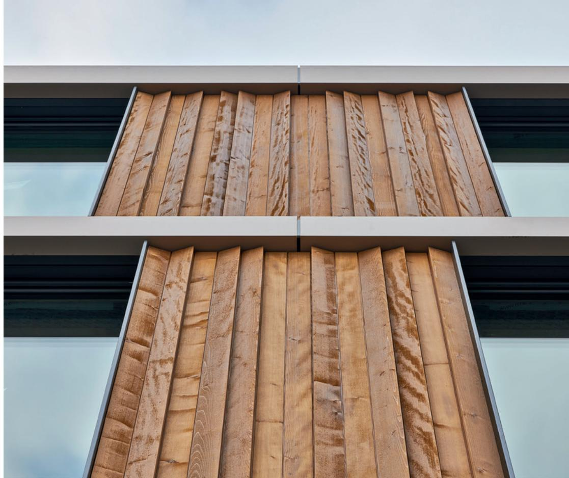
die optisch dominante vorgehangte Fassadenflache von 1600m<sup>2</sup> fur die obersten drei Geschosse, dem Bettentrakt. Diese besteht aus 8 unterschiedlichen Elementen, die ein Gewicht zwischen 100 und 300kg aufweisen. Fur jedes dieser Elemente wurden 6 verschiedene profilierte Bretterarten im Werk in Stein AG vorfabriziert und gemass Architekturkreation zusammengestellt. Eine besondere Herausforderung stellten dabei die sehr hohen Anforderungen des Brandschutzes dar.
