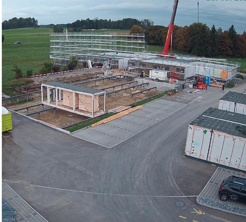
Eindrucklich zeigt sich hier ein erfolgreich realisiertes Re-Use-Beispiel: Modul-Elemente des Alterszentrum Seewadel Affoltern a.A werden zügig demontiert ...
