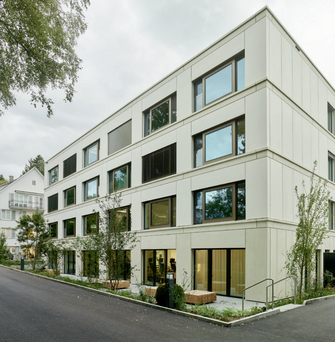
La clinique privée Linde, Bienne, présente une façade avec des éléments préfabriqués en bois et un revêtement en béton fibré et des fenêtres bois-métal en chêne.
